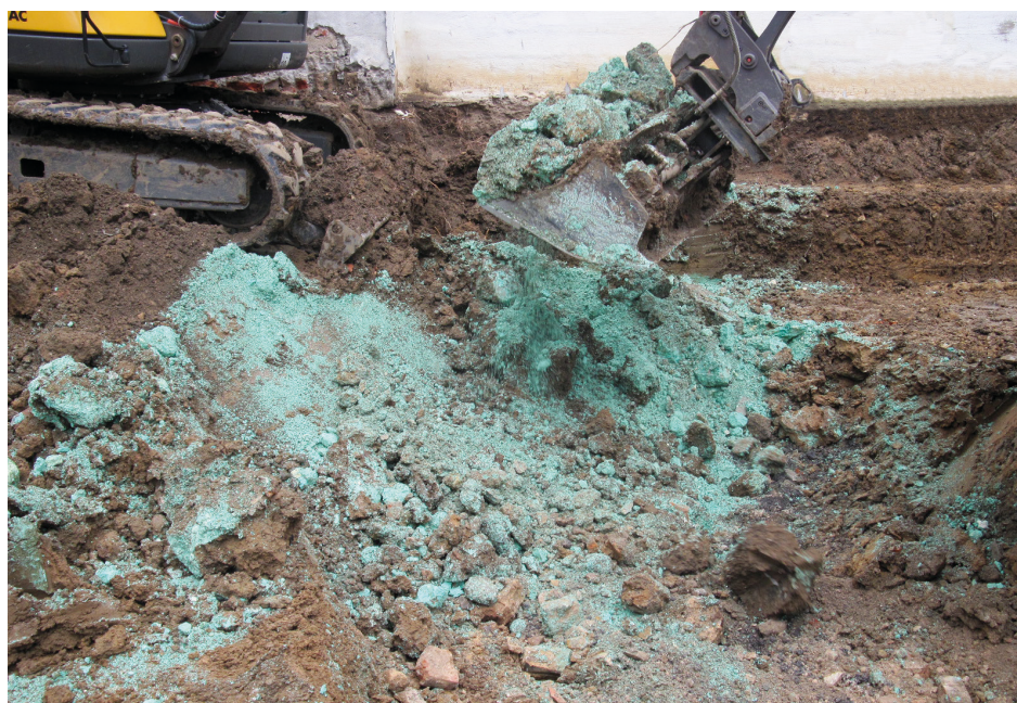
Oben: Gebäudeabbruch im Rahmen der städtebaulichen Neuordnung. Schonungen hat nach der Altlastensanierung ein attraktives Wohnquartier gestaltet. © Philipp Hartmann, Schonungen Unten: Abtragung des kontaminierten Bodens. Die Verunreinigungen sind vor allem auf den Farbstoff „Schweinfurter Grün“ zurückzuführen, der dort viele Jahre lang in den Fabriken der Firma Sattler hergestellt wurde. © Landratsamt Schweinfurt
