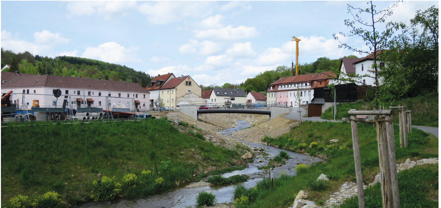
Zur Aufwertung des Wohnquartiers in Schonungen tragen auch die Sanierung der Steinach und der Bau von neuen Fuß- und Radwegbrücken bei. © Philipp Hartmann, Schonungen
