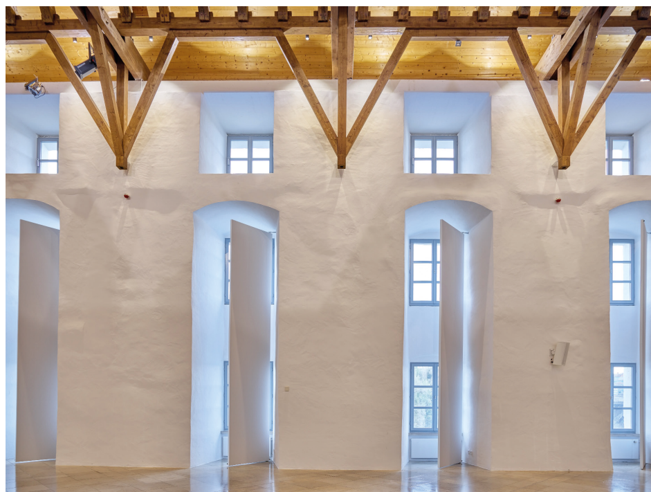
Im Rittersaal dienen sechs Meter hohe, bewegliche Innenläden, die mit Stoff bespannt wurden, zur Verbesserung der Akustik und zur Abdunkelung der Räume. © Marcel Peda, Passau
