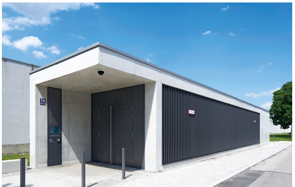
Oben: Das Foyer des neuen Gebäudes wird durch die Oberlichter großzügig mit Tageslicht versorgt. Mitte: Die neue Sporthalle der JVA München, die für den Gefangenen- sowie für den Beamten-sport genutzt wird. Bislang standen nur Außensportplätze und einzelne Fitnessräume zur Verfügung. Unten: Das Zugangsgebäude. © Alle Fotos: Stefan Müller-Naumann, München
