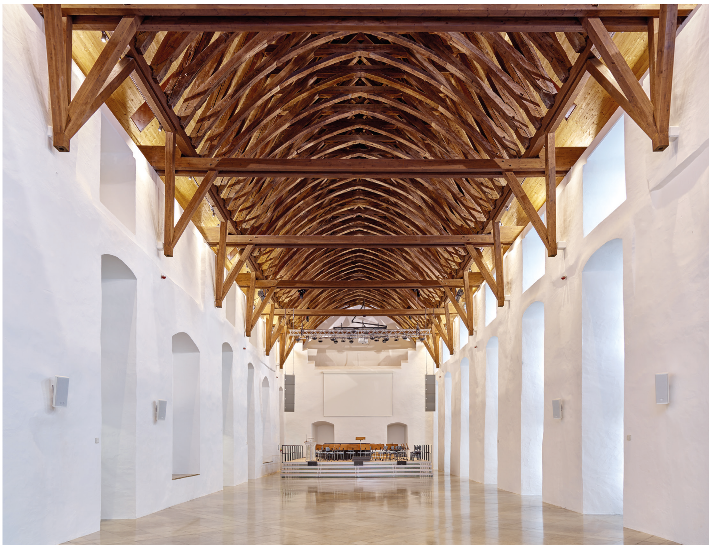
Der Rittersaal wurde 1422 nach holländischem Vorbild errichtet und soll einer der größten Festsäle des Mittelalters gewesen sein. Sein Dachstuhl in Form eines Schiffsrumpfes gilt als Meisterwerk mittelalterlicher Zimmermannskunst. Im Rahmen der Sanierung wurde der Saal mit neuer Audio- und Video-technik sowie mit Saal-, Bühnen- und Effektbeleuchtung ausgerüstet © Marcel Peda, Passau
