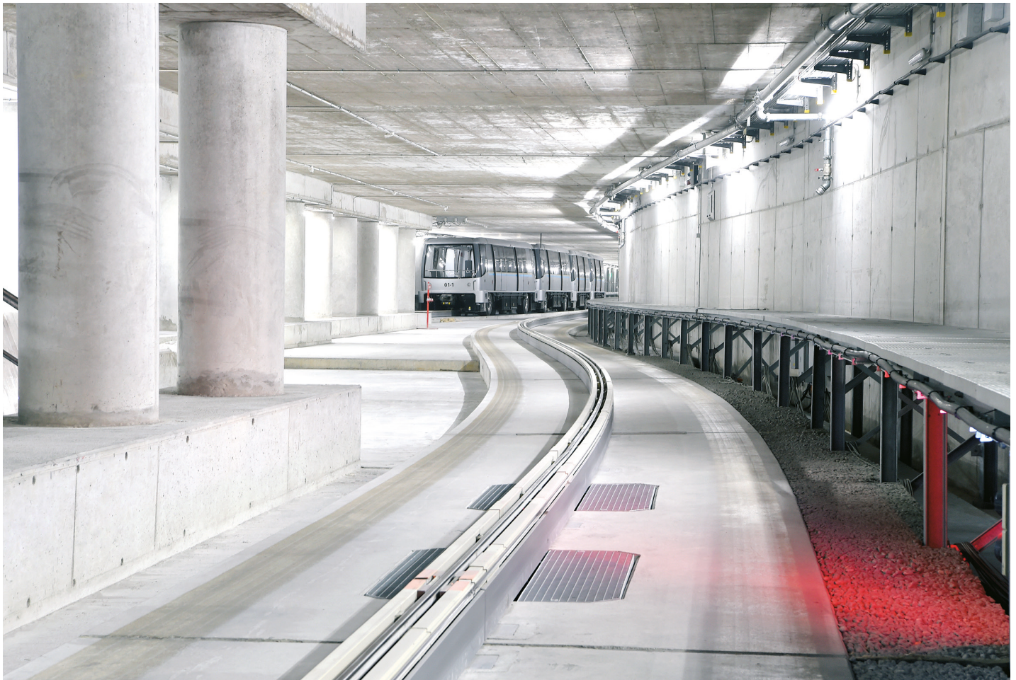
Die Züge verkehren fahrerlos im knapp 400 Meter langen unterirdischen Tunnel zwischen dem Terminal 2 und dem Satelliten-Terminal. Pro Stunde können mit dem Personentransportsystem rund 22.000 Fahrgäste befördert werden. © Flughafen München
