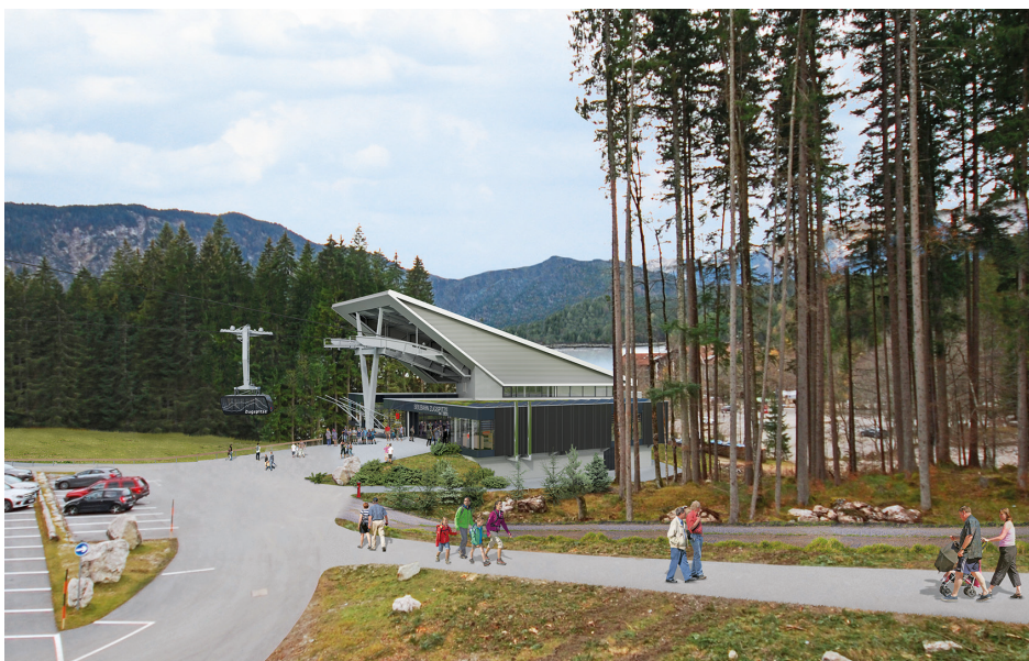
Oben: Die neue Bergstation auf der Zugspitze. Von der Gipfelterrasse aus eröffnet sich den Besuchern ein spektakulärer 360-Grad-Panoramablick. Die neuen Großkabinen in Parallelogramm-Form sind bodentief verglast. Unten / Mitte: Die barrierefreie Talstation.
