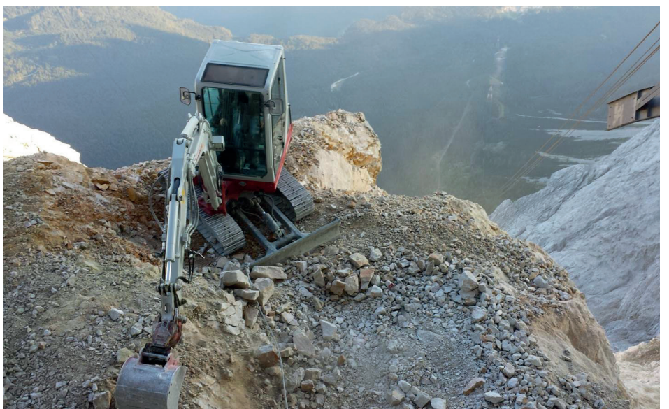
Oben: Die Bauarbeiten an der Bergstation der Zugspitze laufen derzeit auf Hochtouren. Mitte: Helmut Schütz (rechts), Leiter der Obersten Baubehörde, besucht die Gipfel-Baustelle mit Peter Huber, technischer Vorstand der Bayerischen Zugspitzbahn Bergbahn AG (BZB). Links unterhalb des Geländers liegt der südseitige Kopf des Rückspannbauwerkes. Unten: Minibagger am Abgrund. Nach den Sprengarbeiten wurde 2015 die Baugrube für das Fundament eines Trageilbturms der Bergstation ausgehoben. © Alle Fotos: BZB
