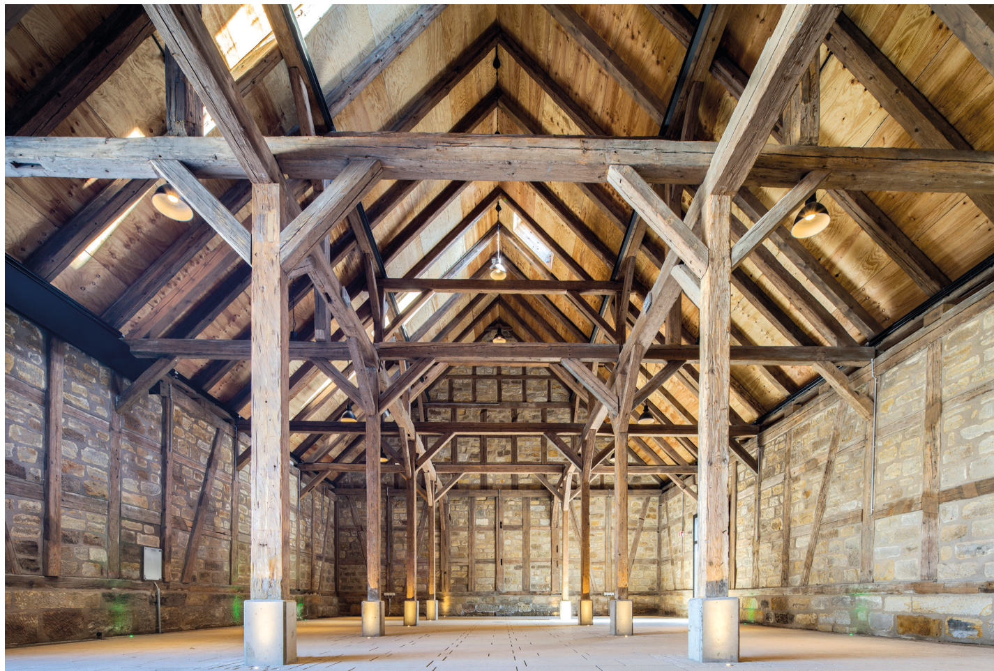
Blick in die „Kalthalle“ der Staatsdomäne Sonnefeld. Sie ist unbeheizt und dient als zusätzlicher Aktiv- und Ausstellungsraum. Neben der „Kalthalle“ dominieren drei weitere Bereiche die revitalisierte Staatsdomäne: eine große Veranstaltungshalle für 300 Personen, ein Foyer und ein Café. © Sascha Kletzsch, München
