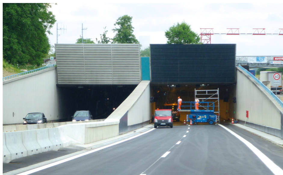
Portal des Tunnels Etterschlag. Nach diversen schweren Unfällen in Straßentunneln (u. a. im Mont Blanc Tunnel, im Tauerntunnel und im Gotthardtunnel) wurde eine neue europäische Tunnelrichtlinie verfasst. Aus Sicherheitsgründen müssen nun alle Tunnel ab einer Länge von 400 Metern nachgerüstet werden, so auch die Tunnel Eching und Etterschlag. © Dr. Christian Hocke
