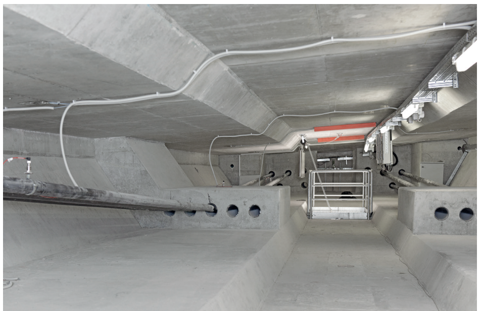
Oben: Nach der Sprengung wurde die Autobahnbrücke konventionell zerlegt. Die Abbrucharbeiten mussten zum Teil nachts durchgeführt werden. Unten: Die „Intelligente Brücke“ liefert nicht nur Informationen über den Verkehr, sondern auch über ihren eigenen Zustand und ihre verbleibende Lebensdauer. Dazu wurden zahlreiche Sensoren eingebaut. (Unten links: Der Fahrbahnübergang mit der sensorbestückter Dehnfuge. Unten rechts: Hohlkasten mit Sensoren im Randbereich der Brücke). © Hajo Dietz
