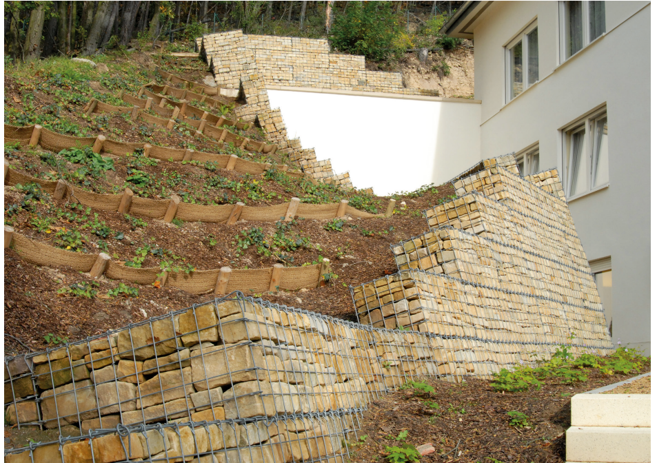
Gabionen lassen sich günstig herstellen und sind daher auch im privaten Bereich sehr beliebt. Sie können selbst an schwer zugänglichen Stellen eingesetzt und als funktionale Elemente eingebunden werden. Häufig ist jedoch nicht bekannt, dass auch Gabionenkonstruktionen technischen Baubestimmungen entsprechen müssen. © Fa. Hoy-Geokunststoffe GmbH
