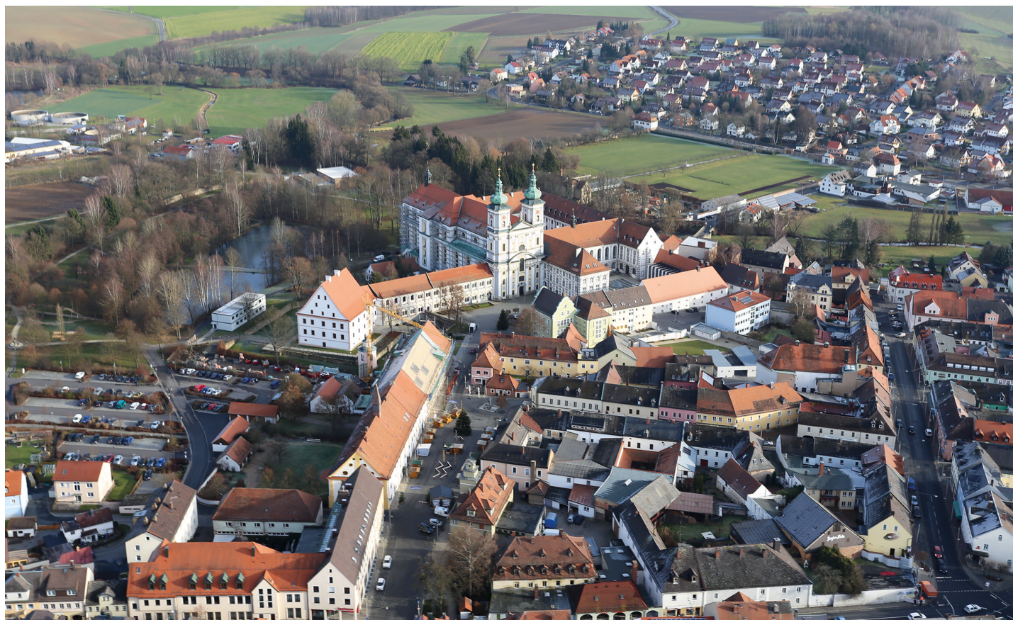
Waldsassen in der Oberpfalz. Der Grundbesitz des 1133 errichteten Zisterzienserklosters umfasste einst eine Fläche von 700 Quadratmetern. Das Kloster wurde in den vergangenen Jahren grundlegend saniert. © Staatliches Bauamt Amberg-Weilburg
