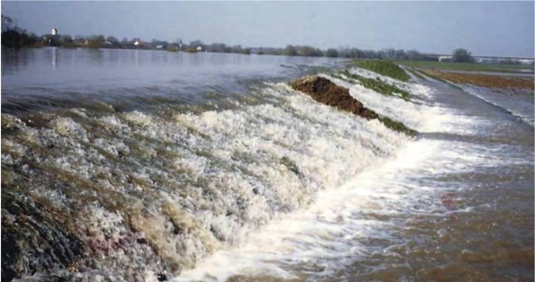
Planmäßige Flutung eines Sommerpolders bei Parkstetten (Donau, HW 1988-08-23)
